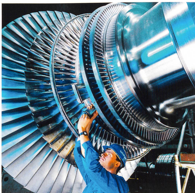
Wartung einer Kraftwerksanlage (Dampfturbinenrotor/Bild Siemens).
