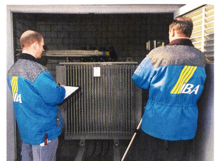
Alles O.K.?: Kontrolle der Stromanschlüsse an einem Verteiltransformator.
