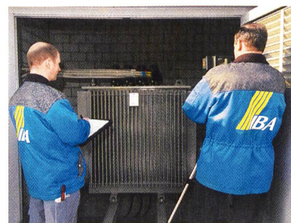
Alles O.K.: Kontrolle der Stromanschlüsse an einem Verteiltransformator.
