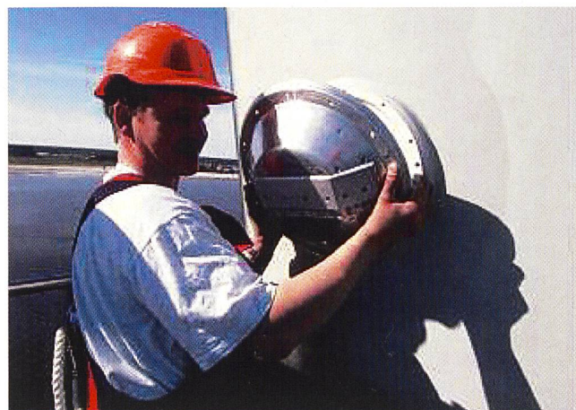
Bild 8 Montage eines Eisdetektors an einer Rotorblattspitze einer Anlage in Finnland.
