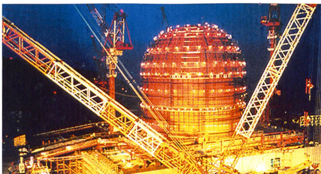
Auch Japan baut weitere Kernkraftwerke (Baustelle «Tomari». Foto MHI/IAEA).
