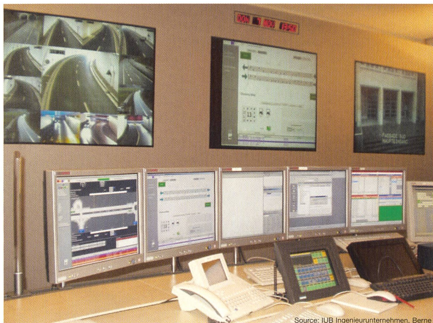
Figure 1 Vue des écrans avec tronçon de tunnel
