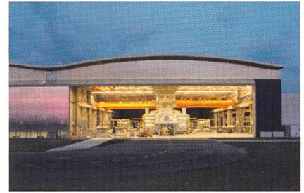
Fertigungshalle für den Bau des bisher grössten Passagierflugzeugs Airbus A380 in Toulouse (Bild: www.presetext.ch)
