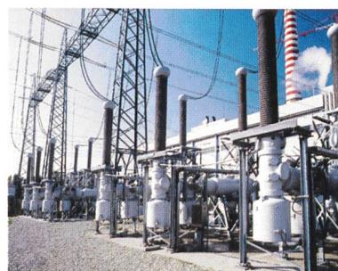
**Titelbild:** Diese hochintegrierte Schaltanlage – eine Kombination von luft- und gasisolierter Schaltanlagentechnik – ist für die Freiluftaufstellung konzipiert und braucht weniger als die Hälfte des Platzes einer vergleichbaren luftisolierten Schaltanlage (Bild Siemens).
