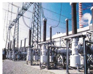
**Titelbild:** Diese hochintegrierte Schaltanlage – eine Kombination von luft- und gasisolierter Schaltanlagentechnik – ist für die Freiluftaufstellung konzipiert und braucht weniger als die Hälfte des Platzes einer vergleichbaren luftisolierten Schaltanlage (Bild Siemens).
