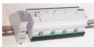
Twiline-Lastbusaktoren LV-D4 und LV-L2EVG von W. Wahli AG
