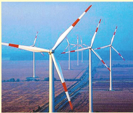
Umfangreiche Förderprogramme für Windstrom (Bild GE).
