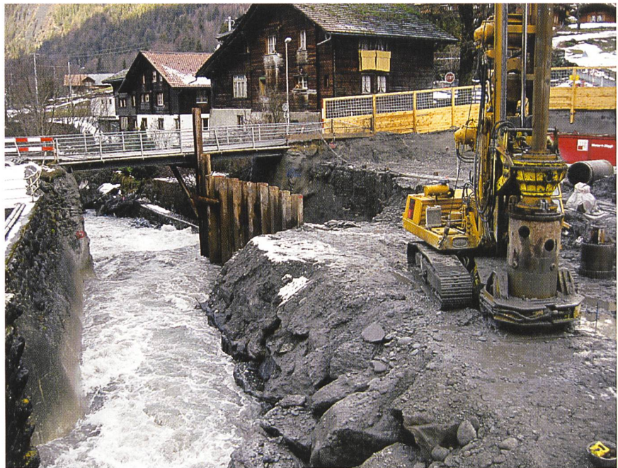
Baugrube «Wehröffnung links»: Vorbohren im grobblockigen Flussgrund für das Einvibrieren der Spundbohlen.
