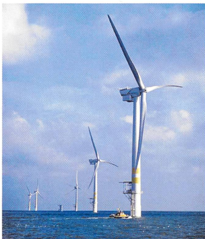
3,6-MW-Maschinen mit 104 m Rotordurchmesser im Windpark Arklow, Irland (Bild GE Wind Energy).
