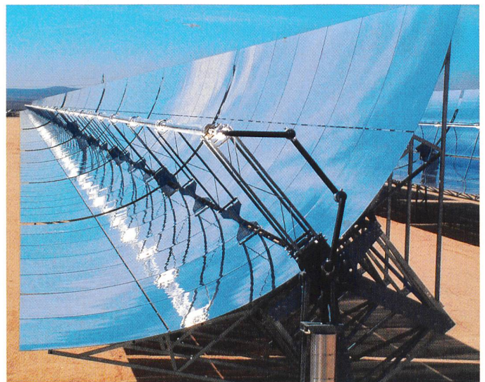
Bild 1 Bei einem Solarkraftwerk wird die Solarstrahlung zunächst in Wärmeenergie umgewandelt, mit der dann über eine Dampfturbine Strom produziert wird (im Bild ein Kollektorstrang/Fotos: Solar Millennium).
