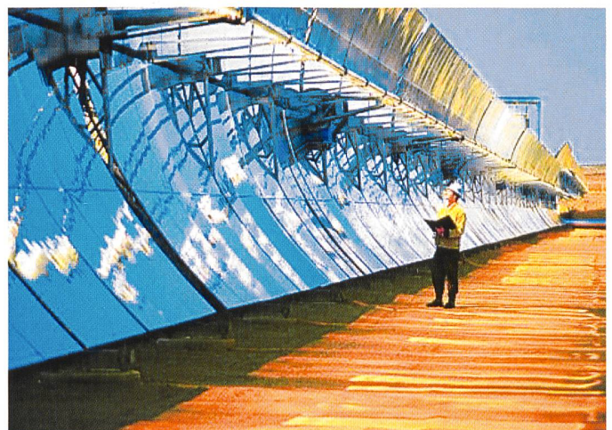
Bild 2 Inspektion einer Parabolrinne.
