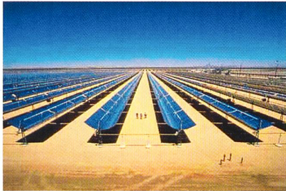
Kollektorreihen im Solarfeld Kramer Junction, Kalifornien.
