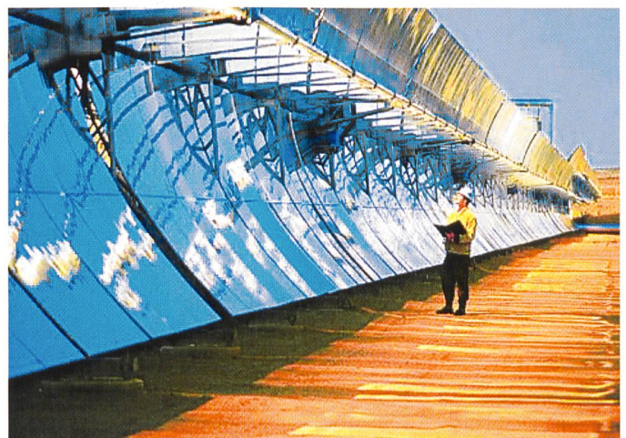
Bild 2 Inspektion einer Parabolrinne.
