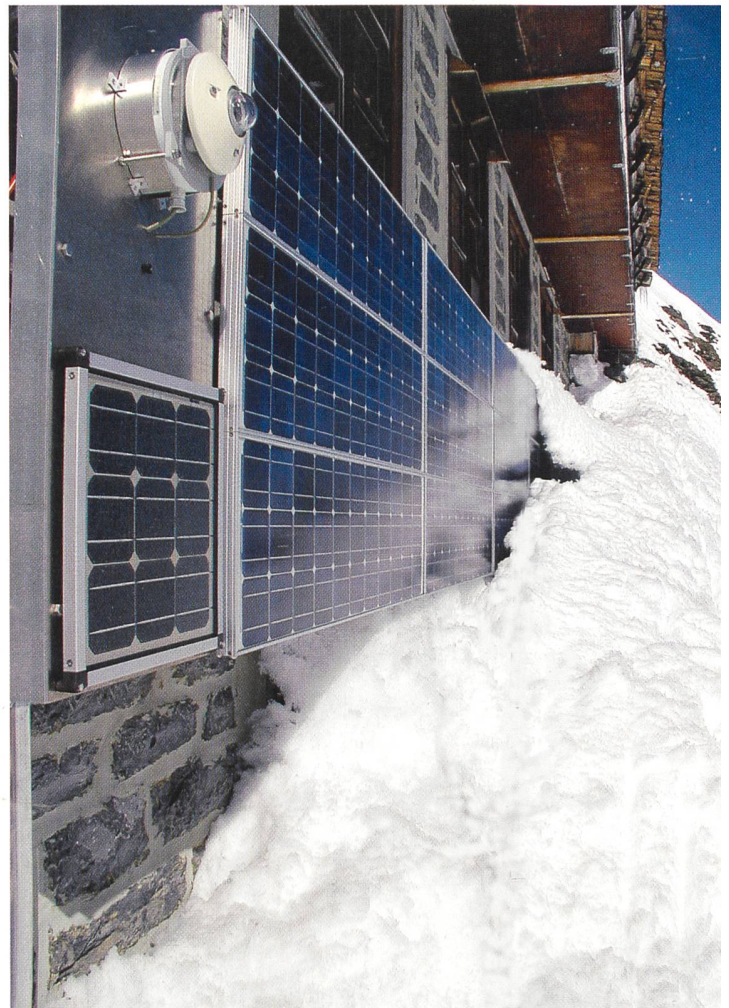
Bild 3 Massive Schneebedeckung der Osthälfte des PV-Generators am 7. Mai 2001. Da je 4 Module in Serie geschaltet sind, ist die Produktion dieses Teilgenerators unter diesen Bedingungen fast 0.
