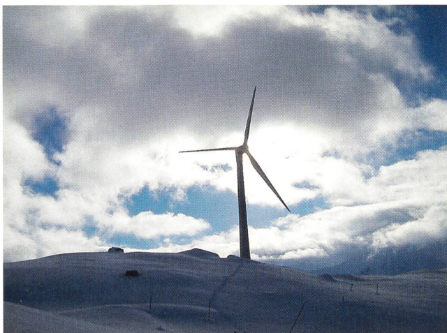
Windanlage auf dem Gütsch (Bild: Suisse Eole).
