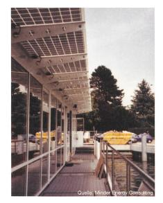
Bild 3 Seitengang mit Ansicht der transluziden Solarmodule
