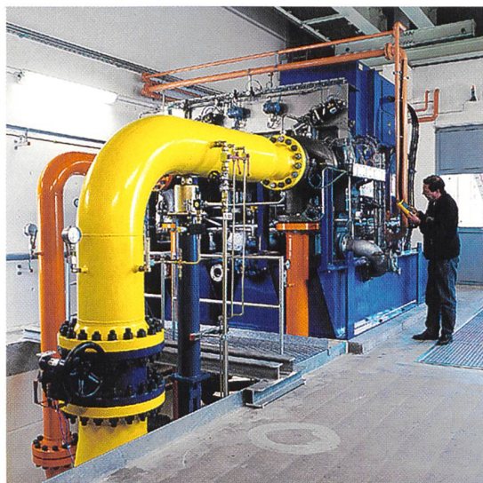
Entspannungsanlage (Bilder: ebm).
