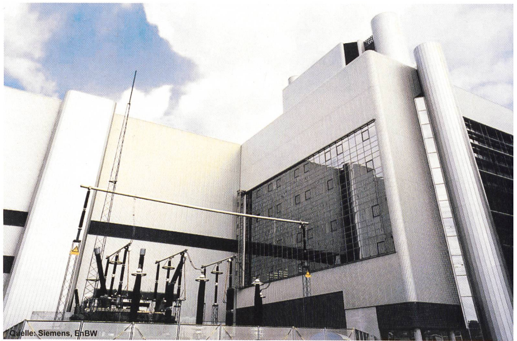
Bild 5 Kombiniertes Gas- und Dampfkraftwerk PGN Altbach in Deutschland.
