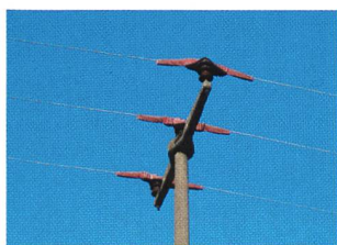
Schutzhauben an Freileitungen.
