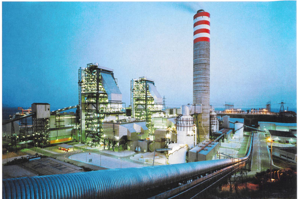
Knapp 3,3 Mio. Tonnen Steinkohle werden in Iskenderun jährlich verstromt, bei Volllast verbraucht das Kraftwerk bis zu 10 000 Tonnen täglich. Das Kraftwerk kann bis zu 8% des Bedarfs an elektrischer Energie in der Türkei abdecken (Foto: STEAG AG).
