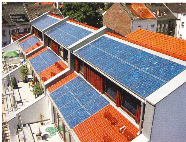
Dafür gibt es in Deutschland viel Geld: PV-Dachanlage.
