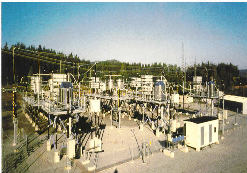
Bild 7 Thyristorgeregelte Serienkompensation zur Leistungsflussregelung langer Leitungen.
