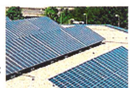
Solkraftwerk P+R Neufeld (Installierte Leistung: 80 kW/ Jahresproduktion: 100 MWh).
