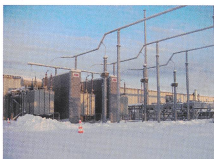
Batteriespeichersystem BESS (Battery Energy Storage System). Ansicht der Transformatoren: links die 138-kV-Zuleitung, rechts die Wärmetauscher der Kühlanlage. Die Abwärme des Stromrichters wird an die Umgebung abgegeben. (Quelle: ABB)
