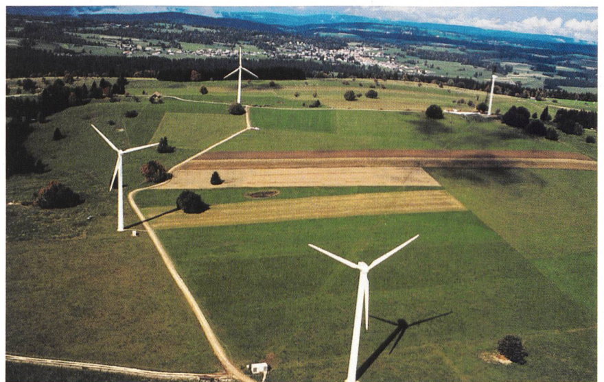
Die auf 1240 m ü.d.M. gelegene Anlage auf dem Mont Crosin erzeugte im Jahr 2003 rund 4,4 GWh elektrische Energie (Quelle: Suisse Eole)
