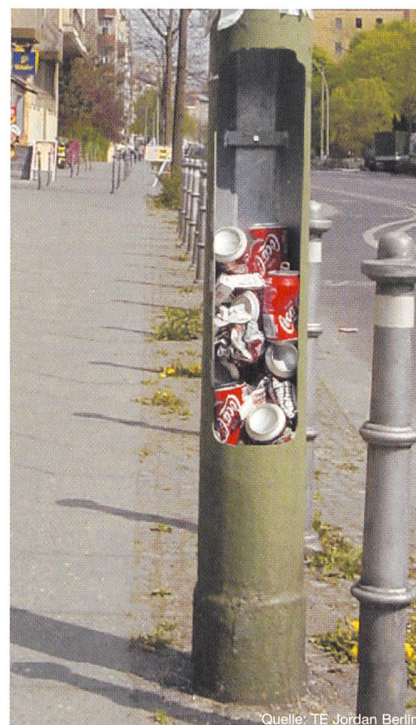
Bild 1 Zweckentfremdung der Lichtmasten
