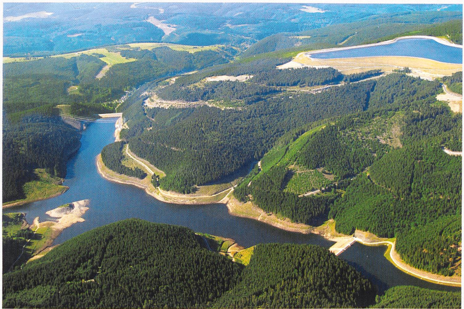
Pumpspeicheranlage Goldisthal (Bild Vattenfall).
