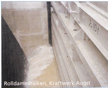
Rolldambalken, Kraftwerk Augst
