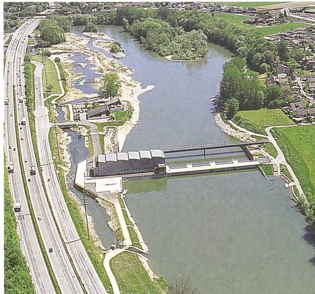
Laufkraftwerke: mehr Wasser im Winter, weniger im Sommer (Aarekraftwerk Ruppoldingen/SO; Foto Atel).
