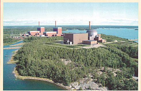
Computerzeichnung des neuen 1600-MW-Kernkraftwerks auf der Insel Olkiluoto an der finnischen Westküste (Bild TVO, im Hintergrund die bestehenden Blöcke 1 und 2, im Vordergrund Olkiluoto 3).
