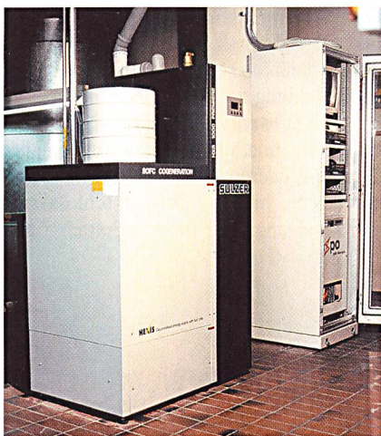
Die Brennstoffzellen-Heisanlage von Sulzer Hexis: Pilotversuch im virtuellen Einfamilienhaus. Aus Wasserstoff und Sauerstoff wird Wasser, Strom und Wärme (Bild: axpo).
