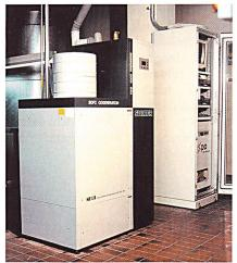
Die Brennstoffzellen-Heizanlage von Sulzer Hexis: Pilotversuch im virtuellen Einfamilienhaus. Aus Wasserstoff und Sauerstoff wird Wasser, Strom und Wärme (Bild: axpo).
