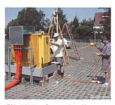
Bild 3 MS/NS-Transformator mit Anschluss-Abschirmhaube über dem NS-Kabelanschluss
