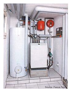
Figure 5 Propre et peu encombrante: une pompe à chaleur datant de 1995
