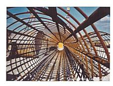
Bild 7 Energiepfahl für Unique Zurich Airport Die Pfähle wurden mit je 10 am Umfang der Armierungskörbe befestigten PE-Rohren ausgerüstet
