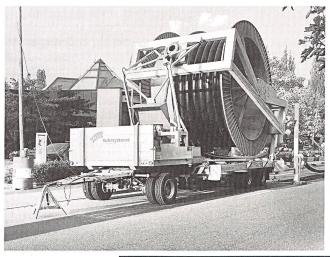
Flexible Fernwärmeleitung vor der Montage, Bild links.
