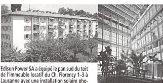
Edisun Power SA a équipé le pan sud du toit de l'immeuble locatif du Ch. Florency 1–3 à Lausanne avec une installation solaire photovoltaïque reliée au réseau, d'une puissance nominale de 38 kW et d'une surface de 300 m².
