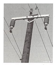
Bild 6 Kombinierte Hängeisolatoren und Überspannungsableiter für Freileitungen bieten mechanische Tragfunktion und Überspannungsschutz in einem Bauteil
