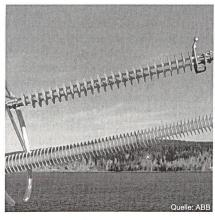
Bild 1 Ableiter für Übertragungsleitungen (TLA)
