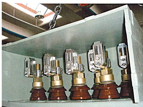
Bild 8 US-Abdeckhaube für 1000-kVA-Transformator.
