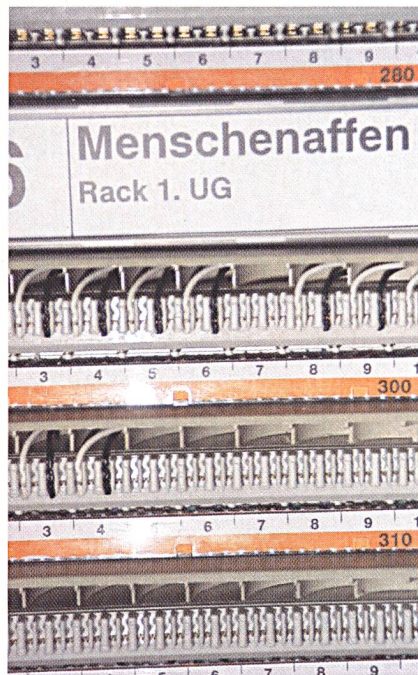
Anschlussleisten VS 83 einer Bucht in der TVA (Teilnehmervermittlungsanlage) Hicom 300
