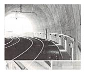
Sicherheit im Tunnel mit GFK-Handläufen von Ebo
