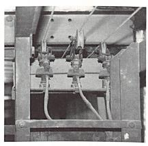
Berührung der offenen Kranschleifleitung hinter einem Trägerbalken Contact avec la ligne d'alimentation ouverte derrière une poutre
