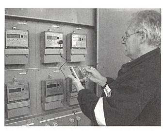
Bild 1 Ablesen mit dem PDA, der über ein integriertes GSM-Mobiltelefon verfügt.
