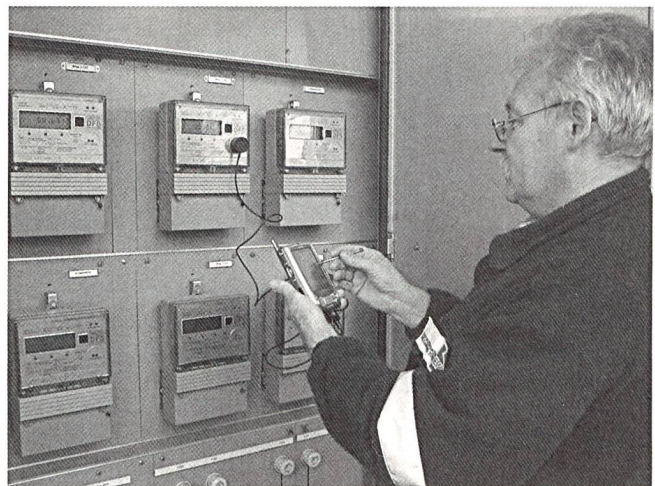
Bild 1 Ablesen mit dem PDA, der über ein integriertes GSM-Mobiltelefon verfügt.
