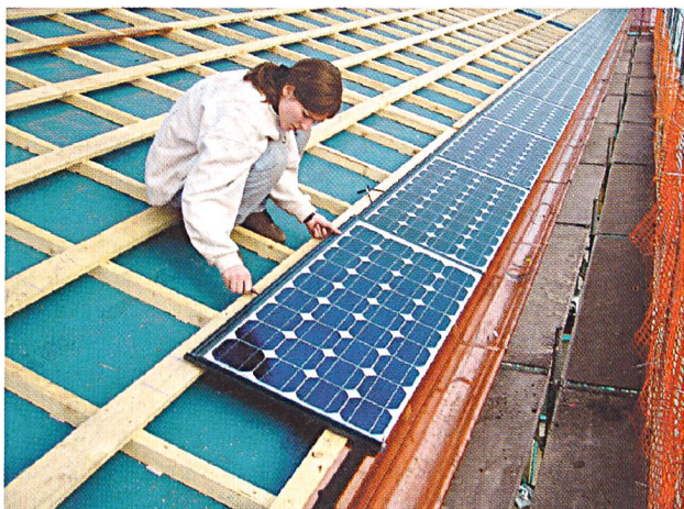
Bild 2 Die Photovoltaik bildet die Dachhaut.
