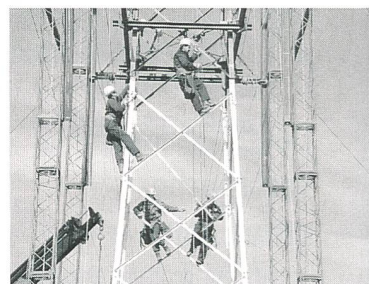
Bau einer Hochspannungsleitung (Bild ABB).
