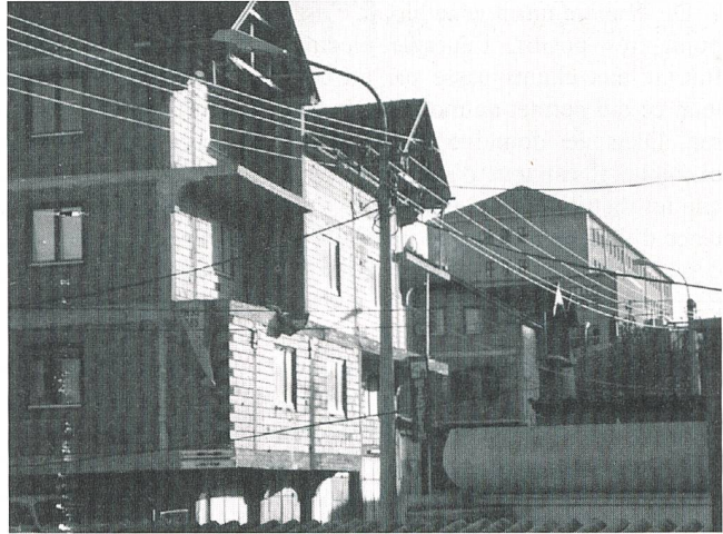
Fig. 3 Réseau aérien basse tension Un réseau un peu embrouillé et surchargé (Gjilan)
