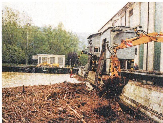
Bild 2 Geschwemmsel am Einlauf eines Flusskraftwerks
