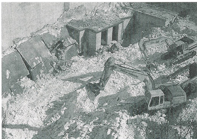
Bild 6 Luftseite der Stauanlage Ferden nach dem Lawinenniedergang vom 23. Februar 1999
