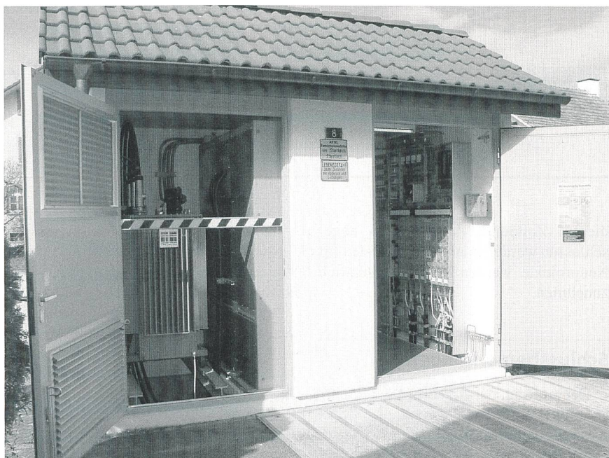
Transformatorstation eines Regionalnetzbetreibers.
