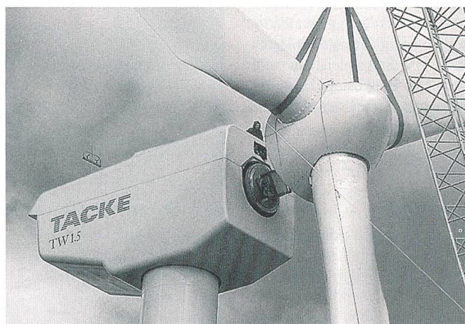
Die Drehzahl des grossen, meist dreiflügeligen Rotors und die des Generators hängt stark von der Windgeschwindigkeit ab (Bild Siemens/Tacke).
