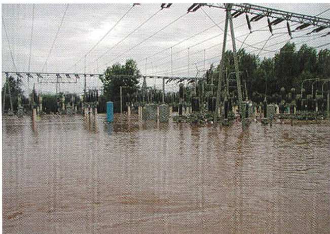
Überschwemmtes Umspannwerk in Sachsen (Bild enviaM).
