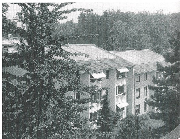
Sonnenkollektoren zur Unterstützung der Warmwasseraufbereitung (Bild Humm).
