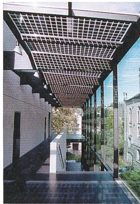
Bild 7 Licht- und Schattenspiel an der Kantonsschule Zürich-Stadelhofen: Hier sind Solarzellen direkt ins Glasdach der neuen Wandelhalle integriert (Bild Gian Vaitl).
