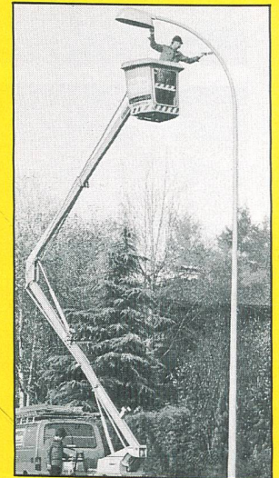
Korrosionsschutz an Stahlkandelabern
